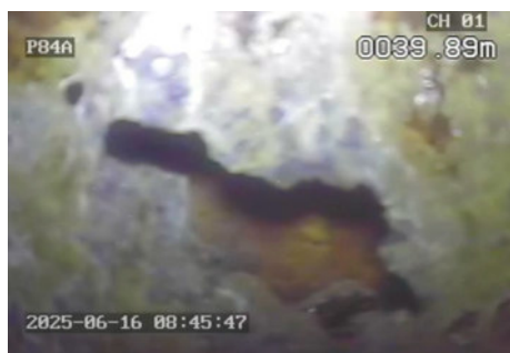
Foto 3. Detalhe do furo no revestimento em 39,9 m
