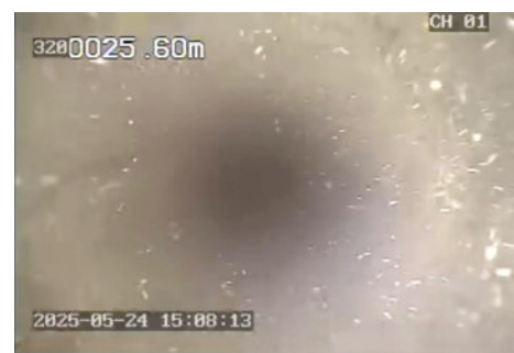
Foto 2. Contato tubo/rocha e turbidez elevada
