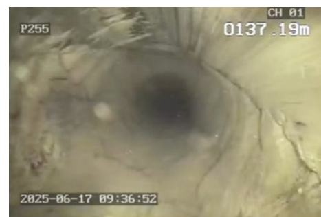
Foto 12. Fratura com quebra da rocha
