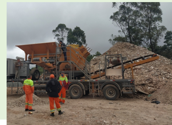
Usina móvel de RCC em operação em Santo André
