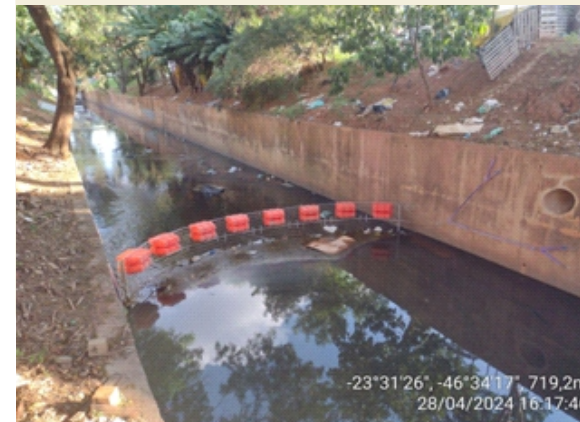
Instalação da barreira flutuante no córrego Novo Mundo
