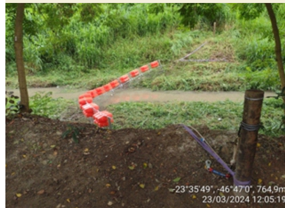
Instalação da barreira flutuante no Córrego Jaguaré
