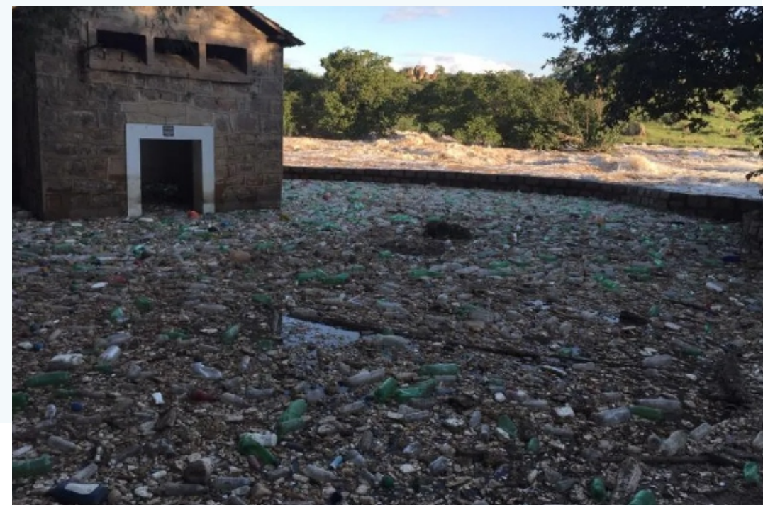
Acúmulo de resíduos no município de Salto durante enchente no rio Tietê. Fonte: Arquivo pessoal/João Conti Neto (2019).
