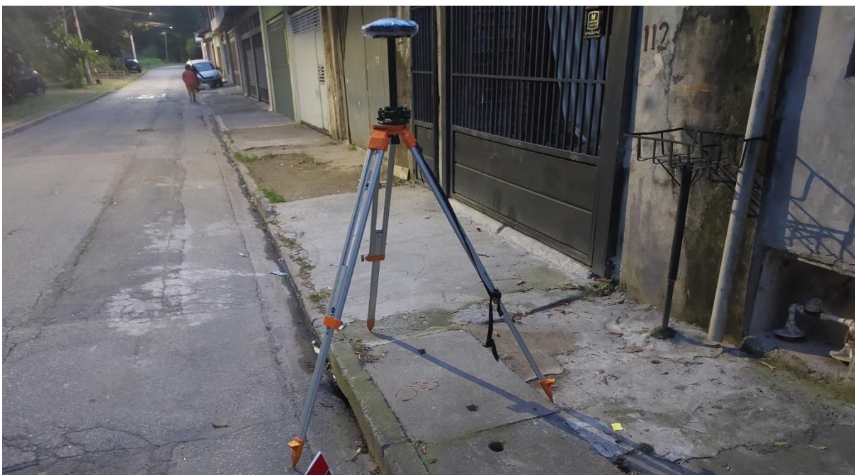
Figura 7: Rastreio do ponto de apoio do córrego Jaguaré.
