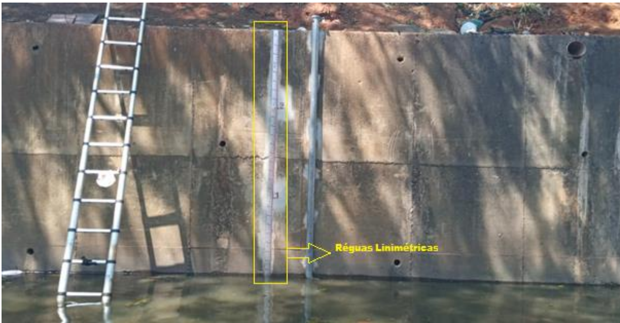
Figura 13: Réguas linimétricas instaladas no córrego Novo Mundo.
