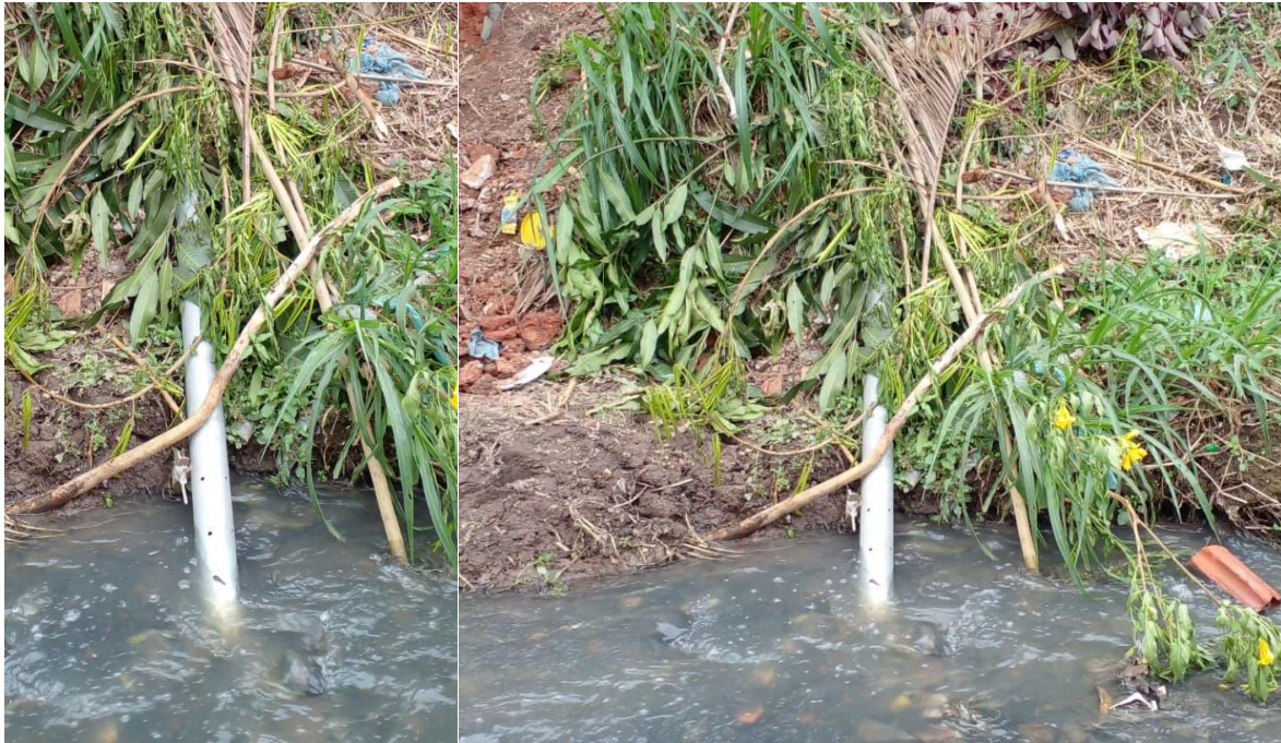
Figura 19: Sonda Onset HOBO Water Level Logger U20-001-01 instalada na estação do córrego Jaguaré.
