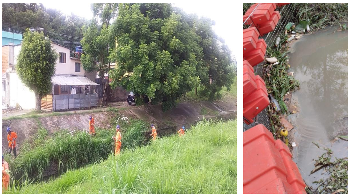
Figura 16: Limpeza e roçada das margens do Córrego Jaguaré.
