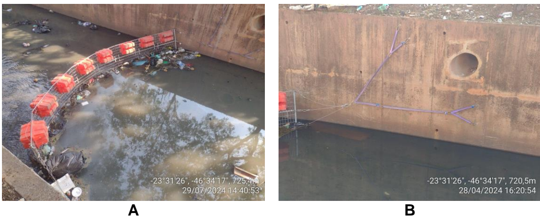
Figura 6: Barreira flutuante utilizada na Sub-bacia do Córrego Novo Mundo.
