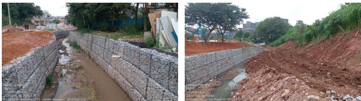
Figura 31: Obras de contenção de margem no Córrego Jaguaré.
