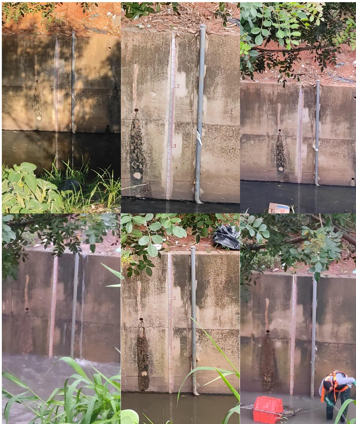
Figura 12: Leituras de nível d'água realizadas nas régua instaladas na estação Novo Mundo.
