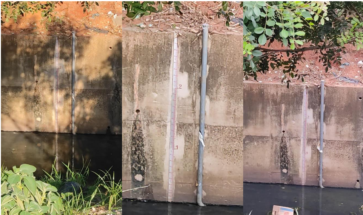
Figura 9: Leituras de nível d'água realizadas nas réguas instaladas na estação Novo Mundo.
