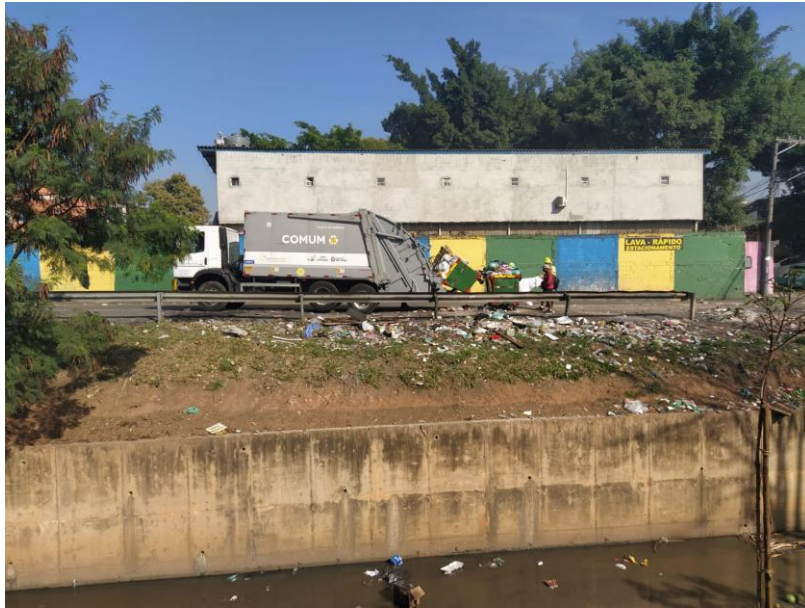
Figura 68: Contêineres coletores de resíduos domiciliares instalados ao lado de córrego na cidade de São Paulo. Excesso de resíduos transportado para dentro do córrego.
