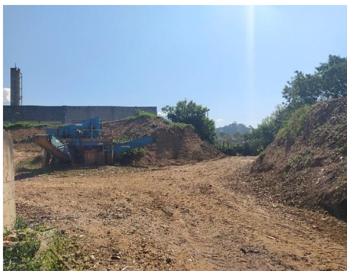
Figura 128: ATT de solo recebido em Ecoponto em Guarulhos.
