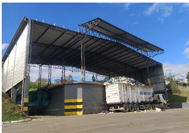
Figura 73: Estação de transbordo em Suzano.
