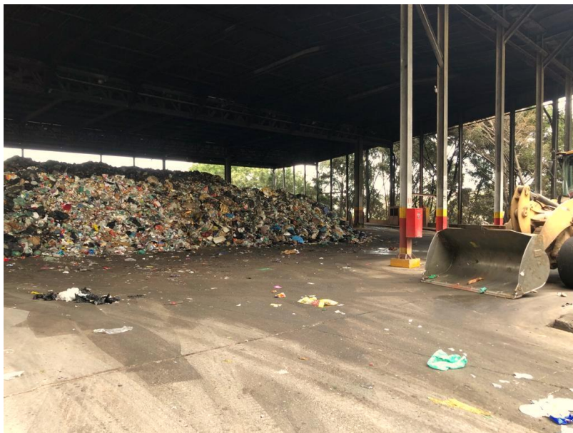
Figura 75: Estação de transferência de resíduos Santo Amaro em São Paulo.
