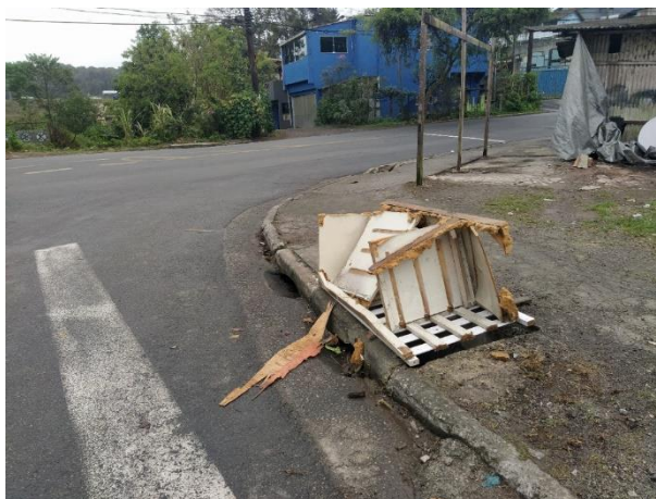
Figura 92: Resíduos volumosos sobre boca de lobo para impedir a queda de pessoas e animais em São Bernardo do Campo. Fonte: EnvEx Engenharia e Consultoria (2023).
