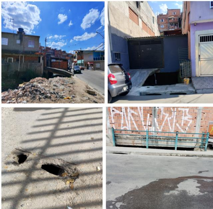
Figura 144: Ocupações irregulares em margens de corpos hídricos em Jandira. Fonte: EnvEx Engenharia e Consultoria (2023).
