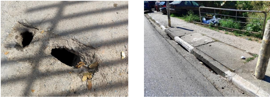
Figura 88: Registro das estruturas de drenagem no município de Jandira. Fonte: EnvEx Engenharia e Consultoria (2023).
