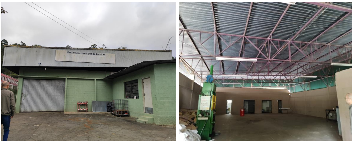
Figura 83:Unidade de triagem desativada em Caieiras.
