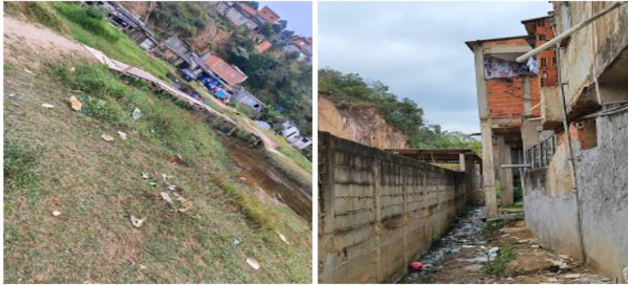
Figura 145: Ocupações irregulares em margens de corpos hídricos em Franco da Rocha.
