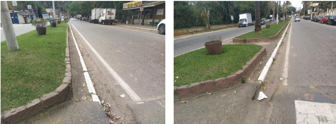
Figura 87: Registro da limpeza pública em vias no município de Paraibuna.
