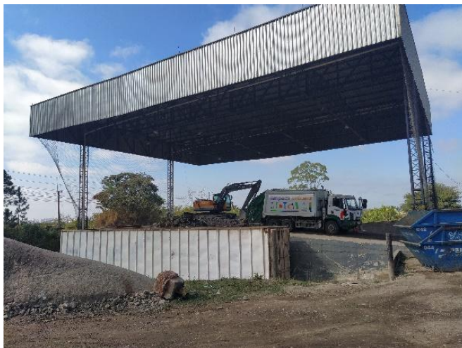
Figura 71: Estação de transbordo em Mogi das Cruzes.
