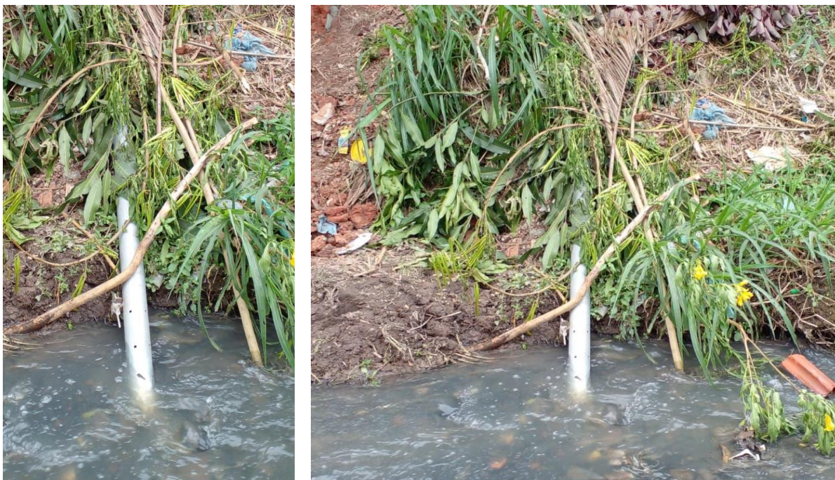
Figura 19: Sonda Onset HOB0 Water Level Logger U20-001-01 instalada na estação do córrego Jaguaré.
