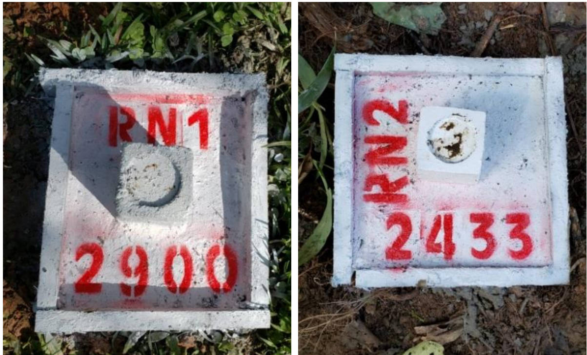
Figura 5: Exemplos de RN's implantadas em estações fluviométricas.
