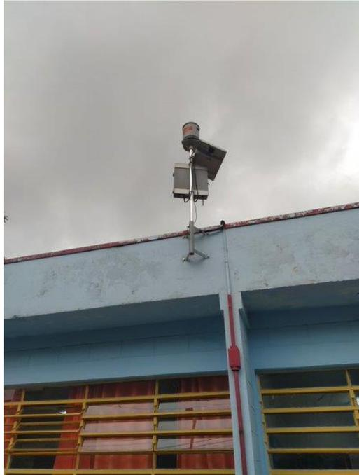
**Figura 23: Estação de monitoramento pluviométrico do CEMADEN presente na sub-bacia do Córrego Botina.**
